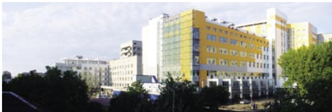
| ККБ. Общий вид
